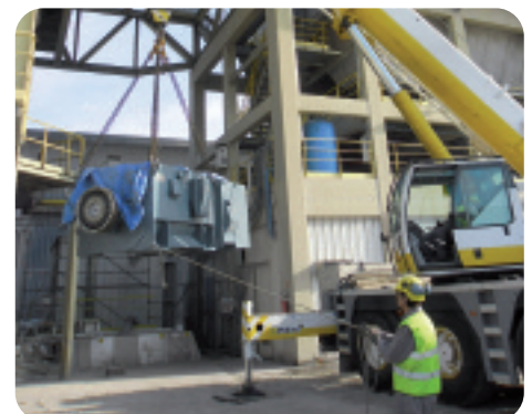
Repose moteur sur site
